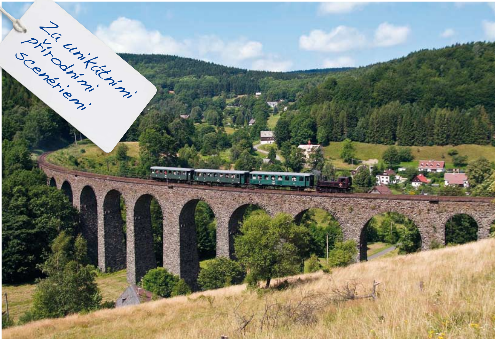
Železniční viadukt Smržovka
